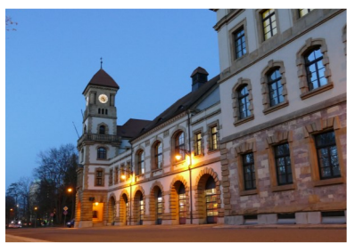
Feuerwache 1, Schadestraße 11, 09112 Chemnitz
