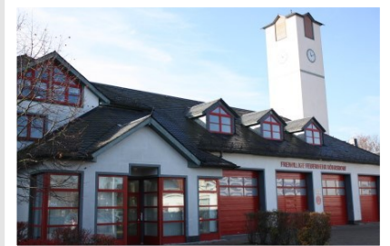
FF Röhrsdorf, Limbacher Straße 25a, 09247 Chemnitz
