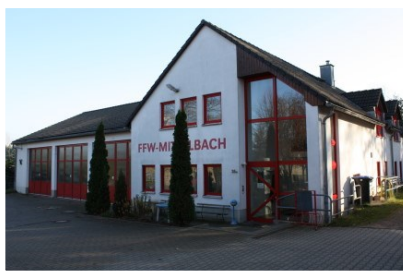
FF Mittelbach, Hofer Straße 35a, 09224 Chemnitz
