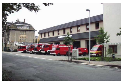
Feuer- und Rettungswache 2, Wilhelm-Weber-Straße 15, 09131 Chemnitz
