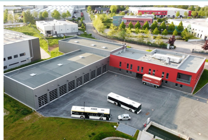
Feuerwehrtechnisches Zentrum von oben
