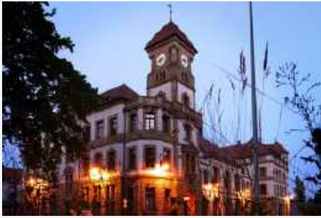
Feuerwache 1, Schäckestraße 11, 09112 Chemnitz
