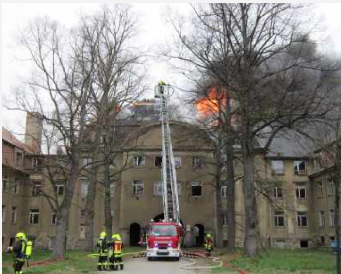
Dachstuhlbrand, Liselotte-Hermann-Straße, OT Gablenz
