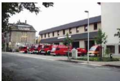
Feuer- und Rettungswache 2, Wilhelm-Weber-Straße 15, 09131 Chemnitz
