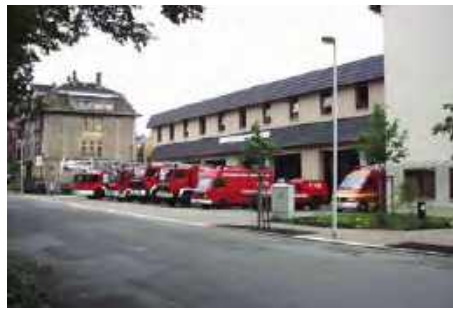
Feuer- und Rettungswache 2, Wilhelm-Weber-Straße 15, 09131 Chemnitz
