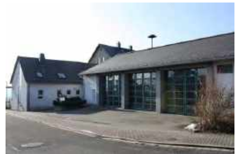
FF Kleinolbersdorf-Altenhain, Johannes-Ebert-Straße 1, 09128 Chemnitz
