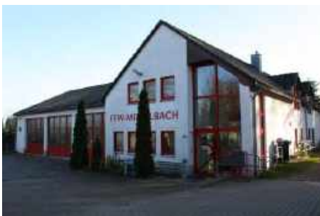
FF Mittelsbach, Hofer Straße 35 a, 09224 Chemnitz
