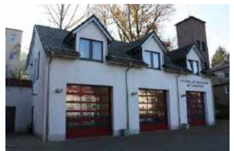
FF Wittgensdorf, Rathausplatz 1 b, 09228 Chemnitz
