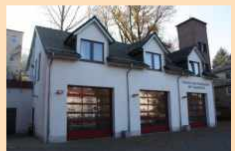
FF Wittgensdorf, Rathausplatz 1 b, 09228 Chemnitz
