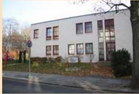
FF Alchemnitz, Uhlestraße 16, 09120 Chemnitz
