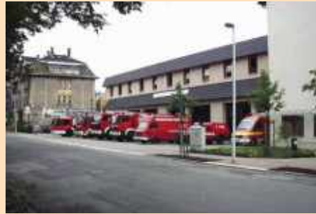
Feuer- und Rettungswache 2, Wilhelm-Weber-Straße 15, 09131 Chemnitz
