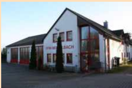
FF Mittelebach, Hofer Straße 35 a, 09224 Chemnitz
