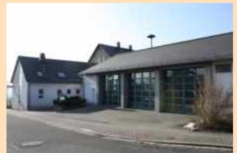
FF Kleinolbersdorf-Altenhain, Johannes-Ebert-Straße 1, 09128 Chemnitz
