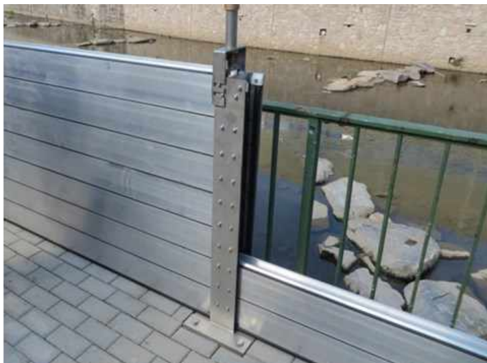
Dammbalkensystem Annaberger Straße
