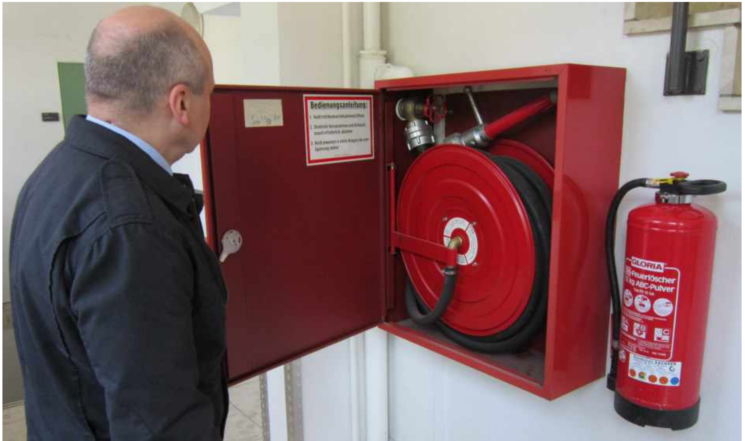
Beim Rundgang vor Veranstaltungsbeginn kontrolliert die Brandsicherheitswache die feuerwehrtechnischen Einrichtungen und kann so Mängel ausschließen bzw. noch rechtzeitig abstellen lassen.
